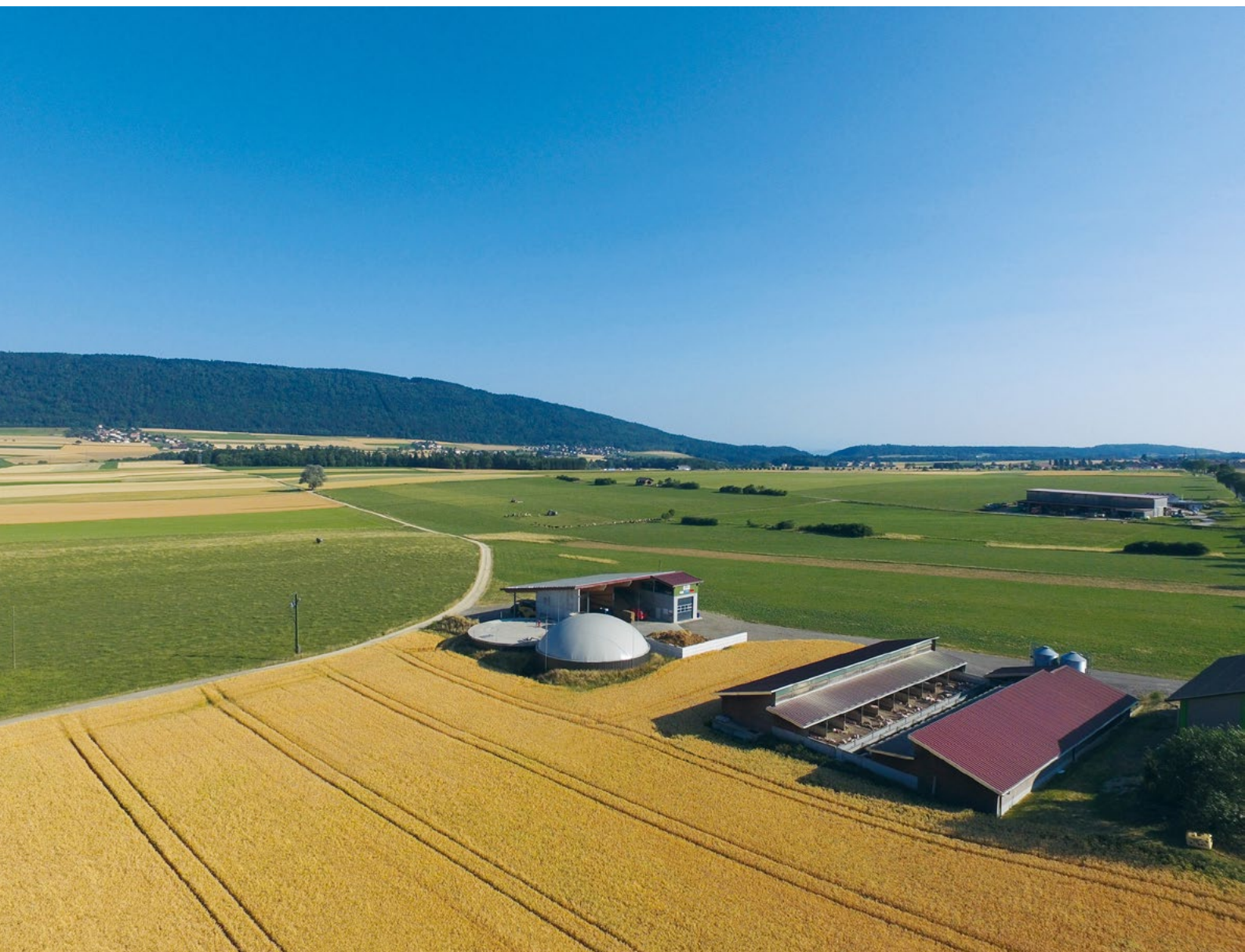
Abbildung 10: Die Biogasanlage Agrenergie SA im Weizen (Bild: Ökostrom Schweiz)
