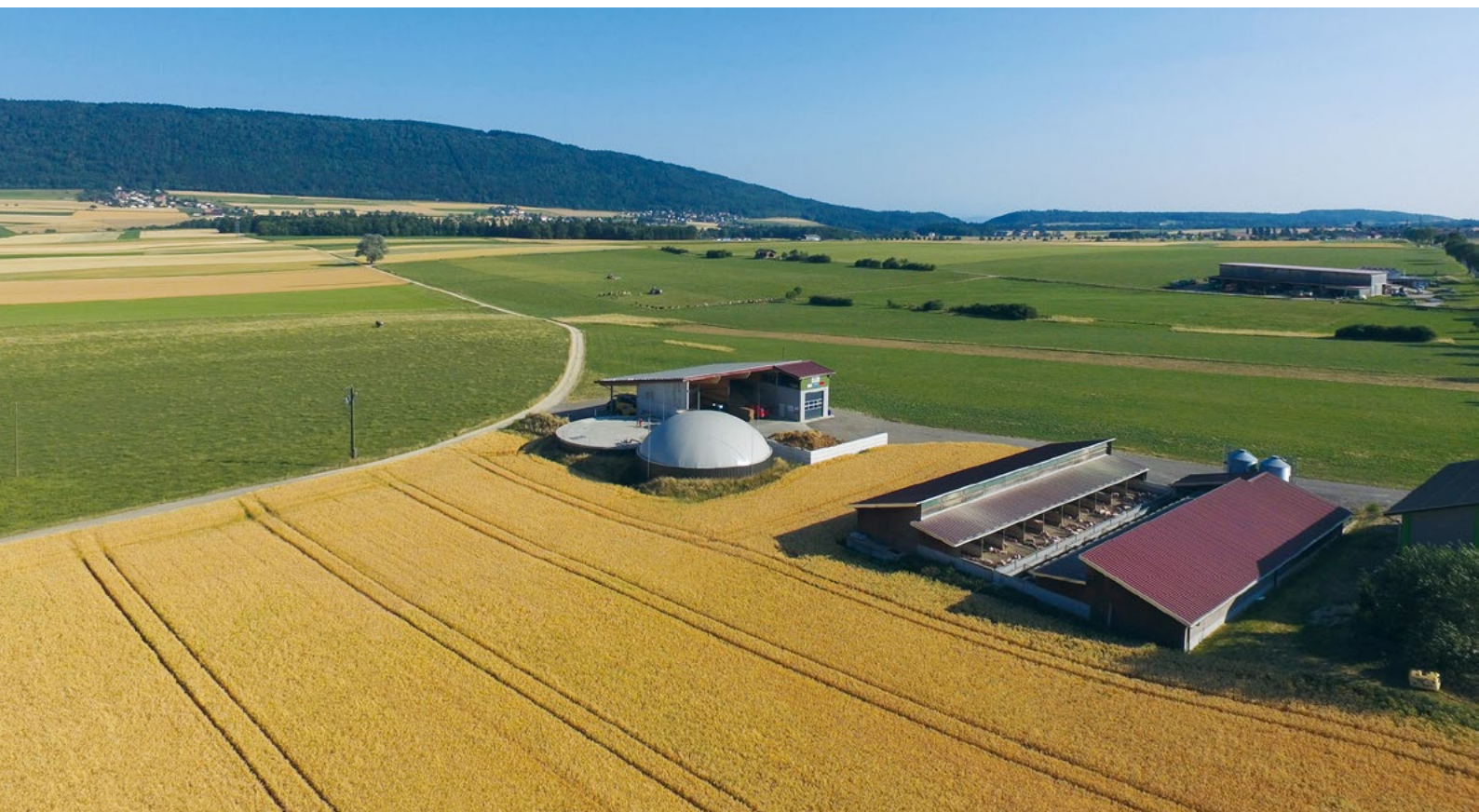
Figure 10: L'installation biogaz Agrenergie SA au milieu du blé (Photo : Ökostrom Schweiz)
