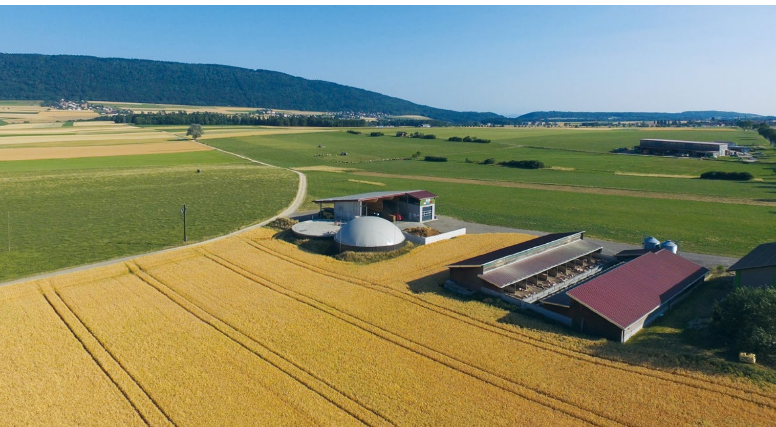
Figura 10: L'impianto di biogas Agrenergie SA a Weizen (Foto : Ökostrom Schweiz)
